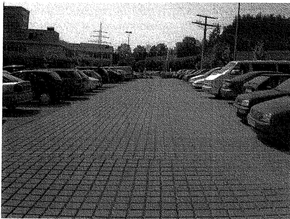
Bestehende Parkierungsanlage mit Rasenfugenpflaster, wasserdurchlässig und gekiesten Stellplätzen
