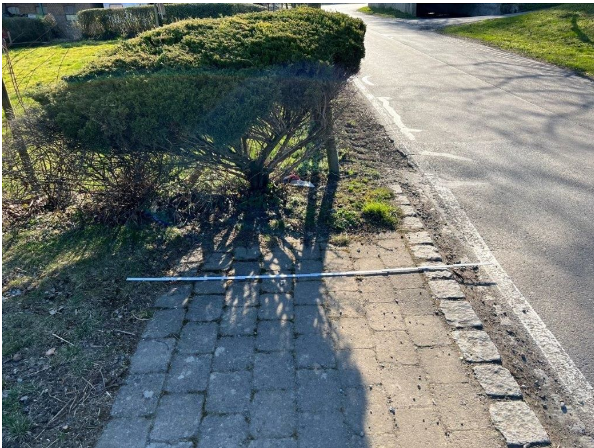
Bild zur Situation am Straßenrand
